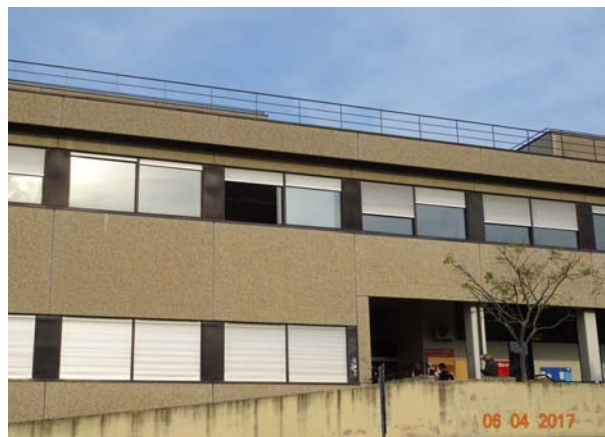
Zdj. 22. Biblioteca Medica - wejście główne do budynku. Fot. M. Błach.
