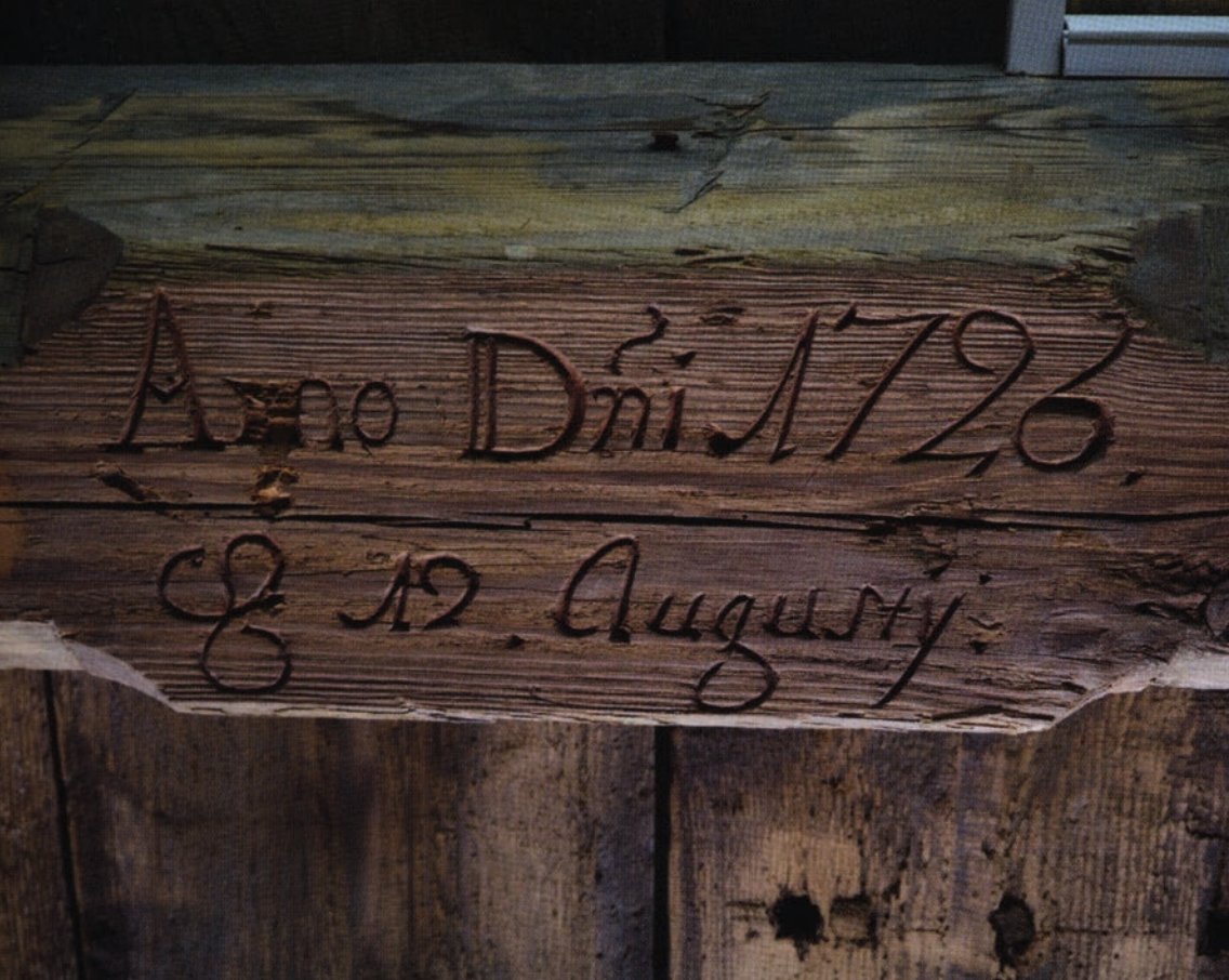
Zdj. 1. Inskrypcja we wnętrzach spichlerza plebańskiego z Tenczynka. Fot. P. Bujakiewicz. Zdjęcie w artykule Anny Latko-Serafińskiej Inskrypcje w zabytkowych obiektach architektury wiejskiej i małomiasteczkowej (s. 183).
